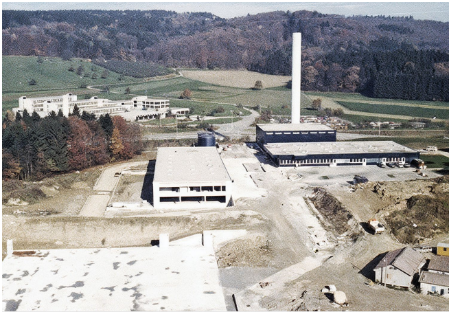
Die Anfänge am Standort Dättwil: Das 1978 eröffnete Kantonsspital Baden während der Bauphase.
