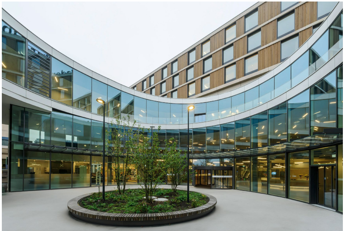
Willkommen im Neubau: Das KSB wurde im November 2025 in Miami mit dem World-Architecture-Festival-Award ausgezeichnet.
